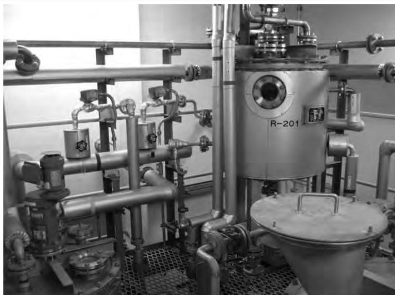
写真107 一次反応槽
