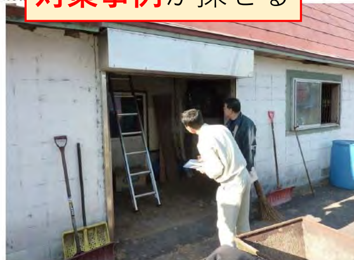
図1 事故現場の部分用牛舎の入り口 (事故当時を再現して梯子をかけている)
